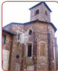
Caramagna Piemonte, Abbazia medievale di S.Maria
